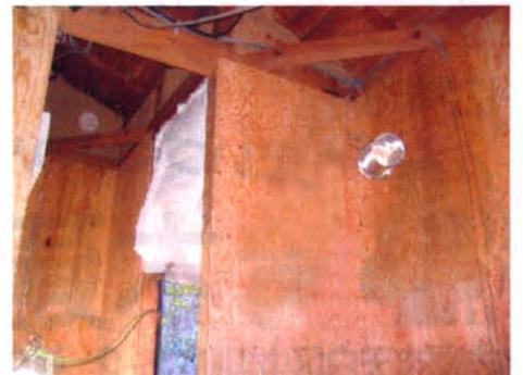
耐力壁 構造用合板補強
