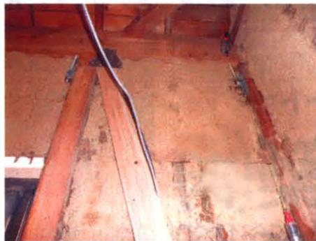
耐力壁筋かい補強
